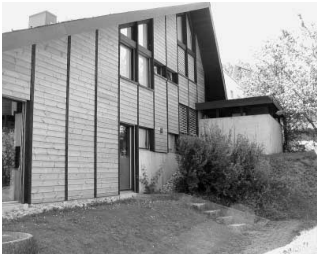
EFH-Fassadenrenovation Erneuerung der Aussenhülle mit Thermowood und neuem Isolationsaufbau
